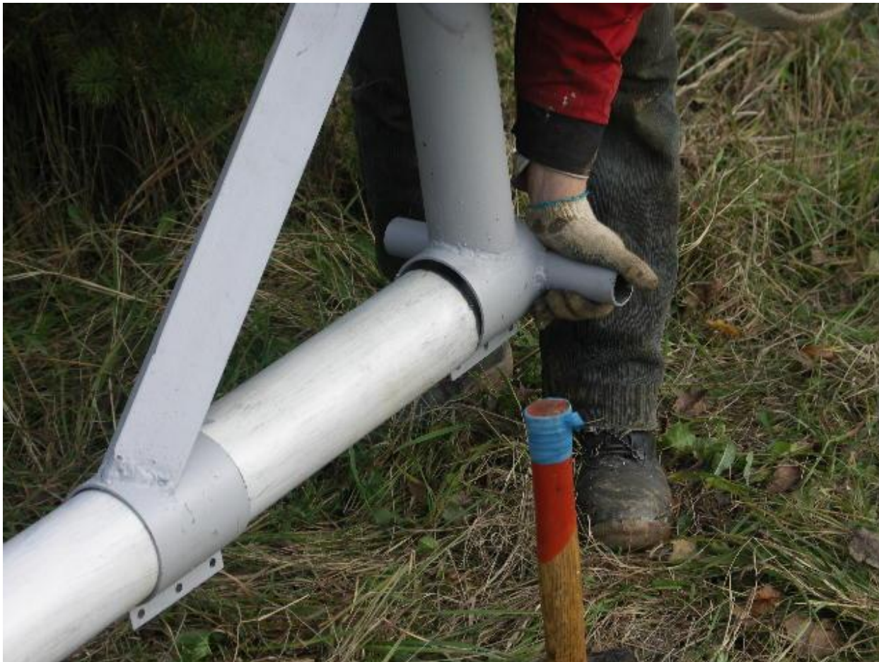
На трубу надевается основание мачты с подъёмным механизмом.
